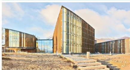
El edificio del Centro Subantártico Cabo de Hornos.
