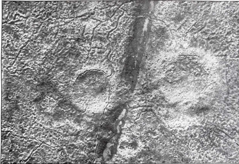
Zwei am Kanal Comins—Ipsen liegende gewaltige Sprengtrichter; der größere hat einen Durchmesser von über 80 Meter.
